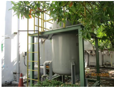
ภาพที่ 2-25 ระบบ Carborn Absorber
